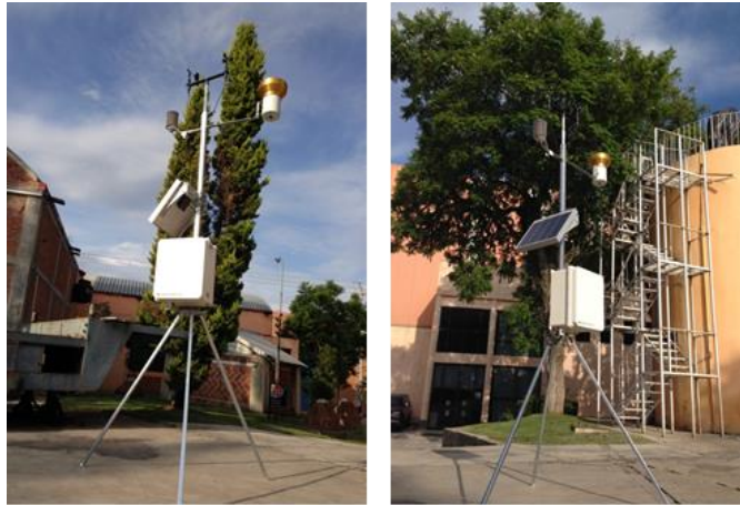
Figura 41. Estación meteorológica en su base.
