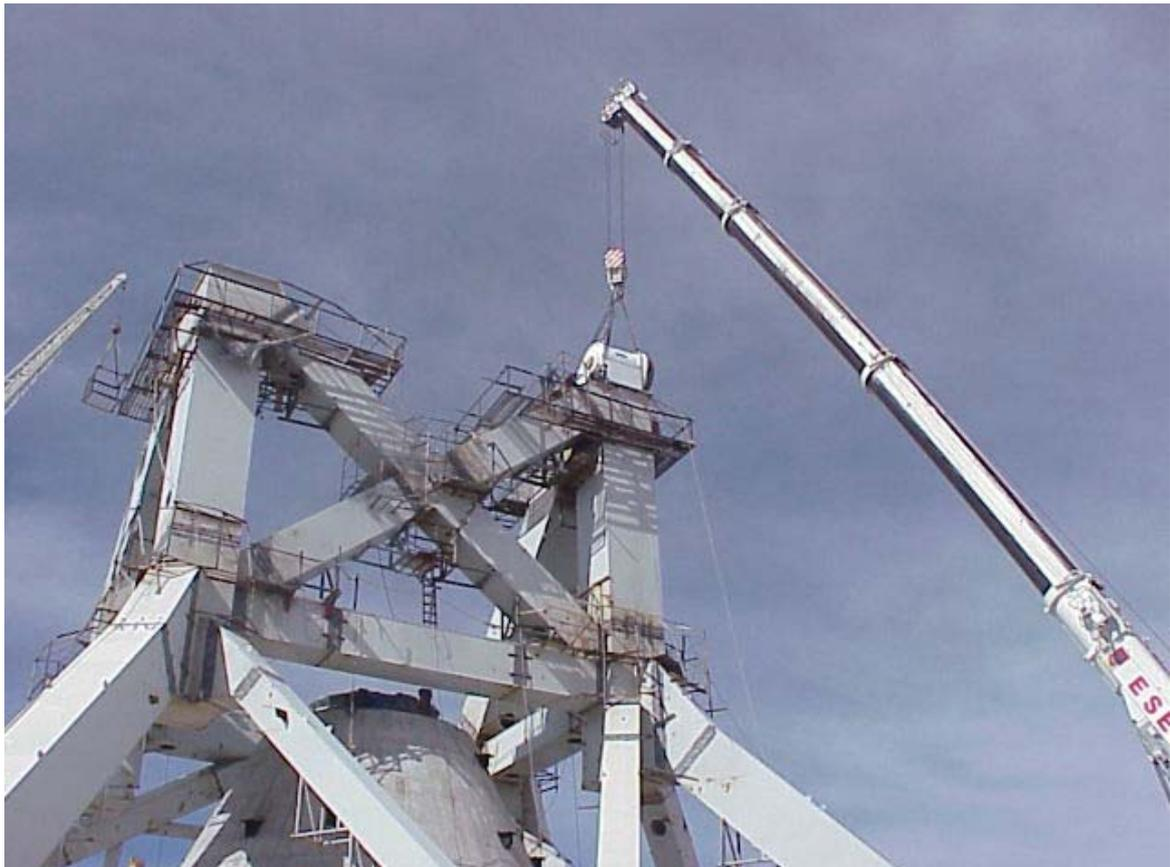
*Figura 10. Colocación del segundo balero de elevación, 10 abril 2004. Se puede observar las plataformas temporales utilizadas para dar acceso a los asientos durante el trabajo con las plantillas.*
