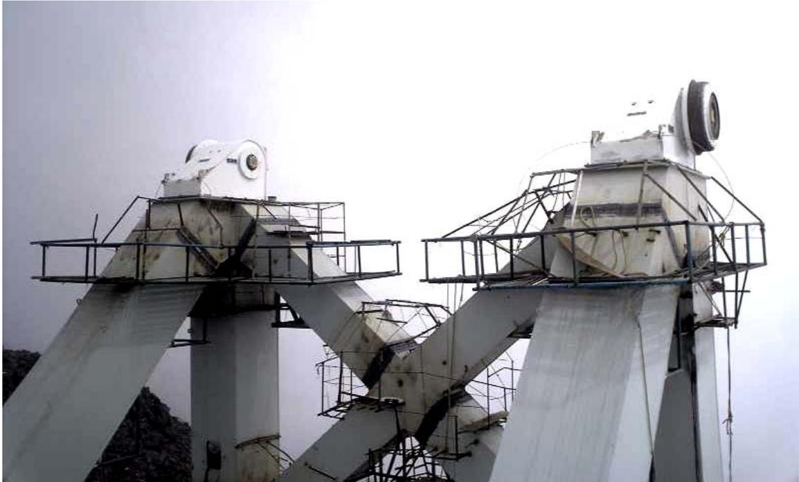
*Figura 11. Ambos baleros de elevación colocados en la estructura del telescopio.*
