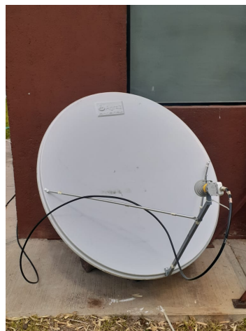
Figura 3.5: Antena offset de 1.2 m usada en el proyecto.
