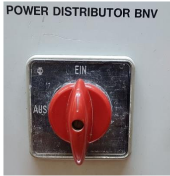
Figura 2. Interruptor para el encendido de la evaporadora.
