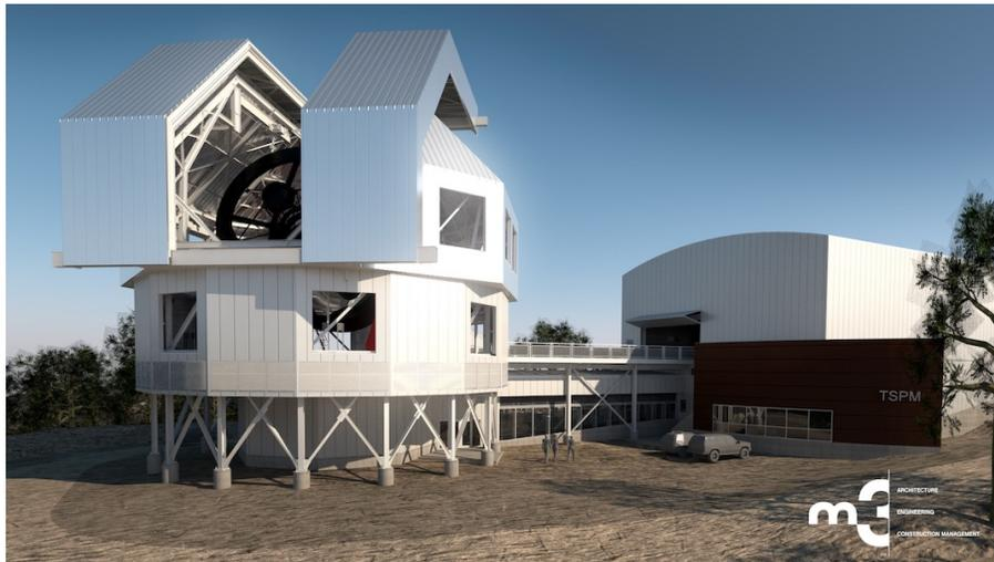
Figura 6.5: Modelo 3D del domo, telescopio y edificio de servicio del proyecto TSPM desarrollado por la empresa M3.
