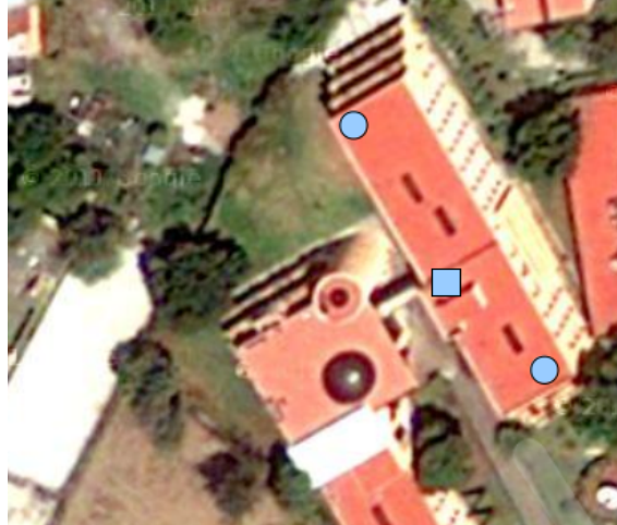
Figura 4.2: Distribución de los elementos del interferómetro. Los círculos representan la posición de las antenas separadas 50 m. El cuadrado representa el bloque de control donde los datos se procesan y se digitalizan. Mapa tomado de: https://maps.google.com/ .
